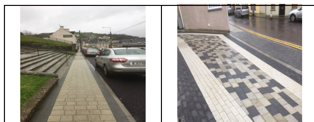
Críochnaíodh oibreacha réimse poiblí ar Shráid an tSéipéil, Beanntraí
